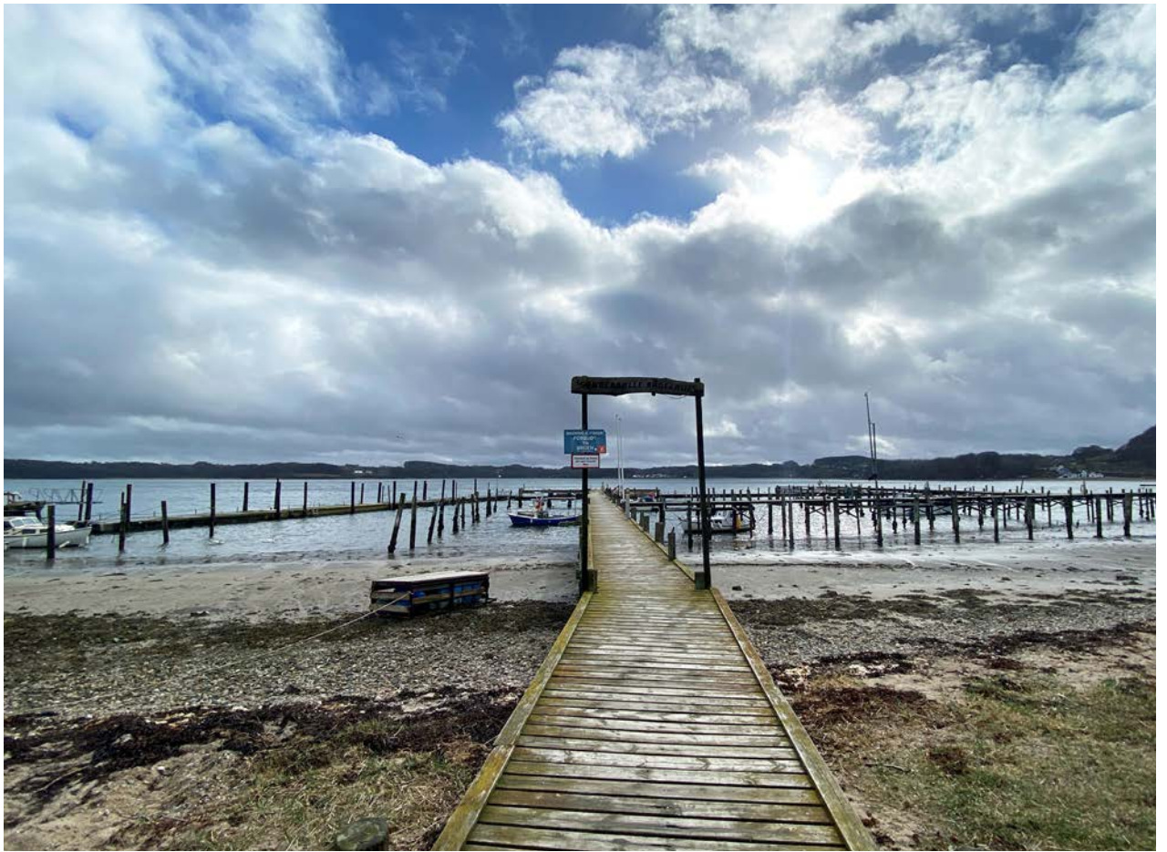
Havneanlægget i dag
